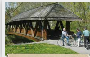
Vor der Murrer Holzbrücke
